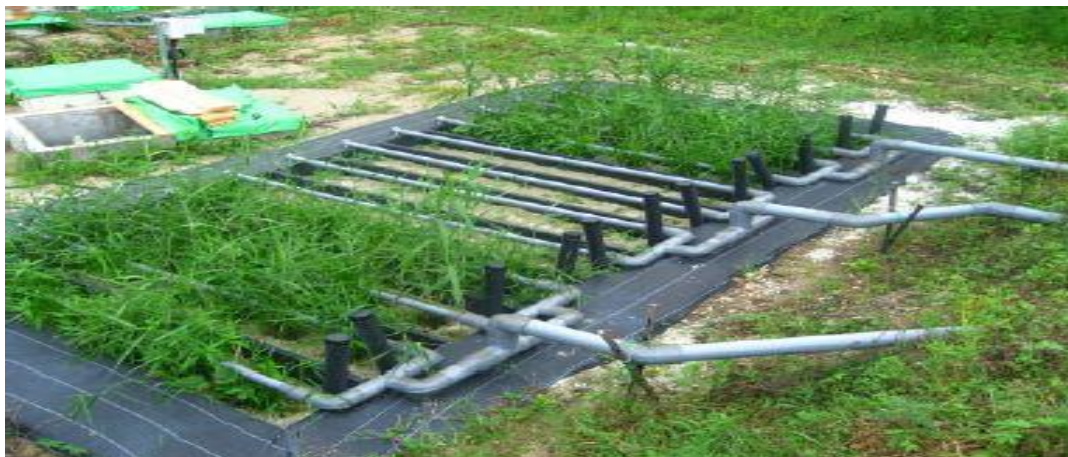
Sistema de humedales artificiales prototipo (Anónimo, redes internacionales: [Fecha de consulta: 6 de mayo de 2015])
