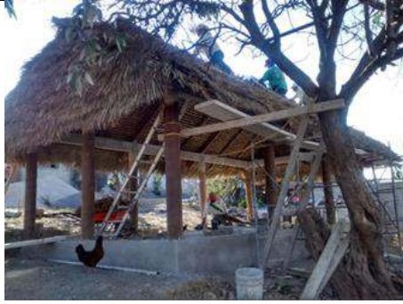
Figura 9. Construcción de una choza con palma dulce ( Brahea dulcis )
