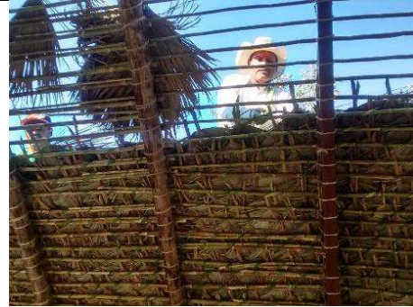
Figura 10. Construcción de techo con palma dulce ( Brahea dulcis )
